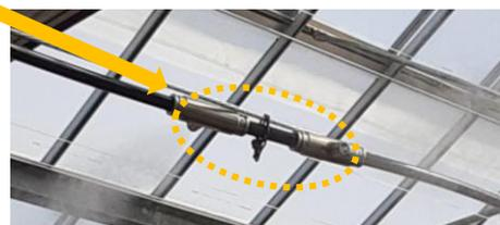
ノズルを同じ場所に異なる向きで2個設置しています。
